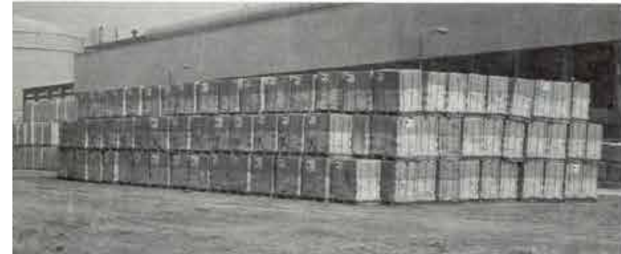
اكثر من مليون طوب حراري تلزم لاعادة بناء البوابات
